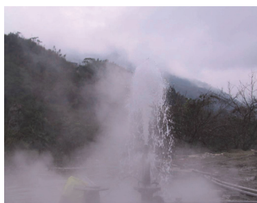
地熱井鑽鑿及完井工程
