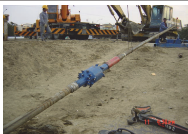
水平井鑽鑿及拉設管線工程
