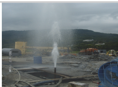
溫水(泉)井鑽鑿及完井工程
