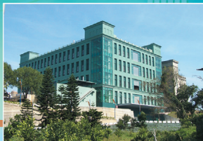
生技廠工程 Biopharmaceutical Plant
