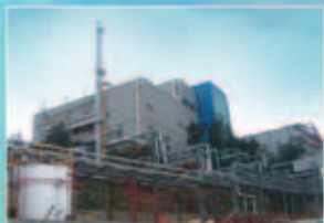
化工廠工程 Chemical Plant
