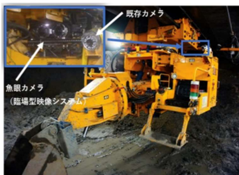
図2 本システム設置掘削機
